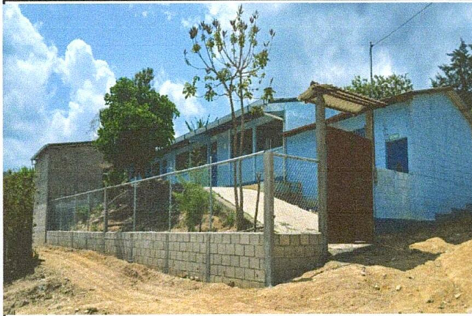
Foto1: Mejoramiento de 82.55 metros lineales con block malla, tubos galvanizados de cerramiento perimetral del centro educativo terminado.
